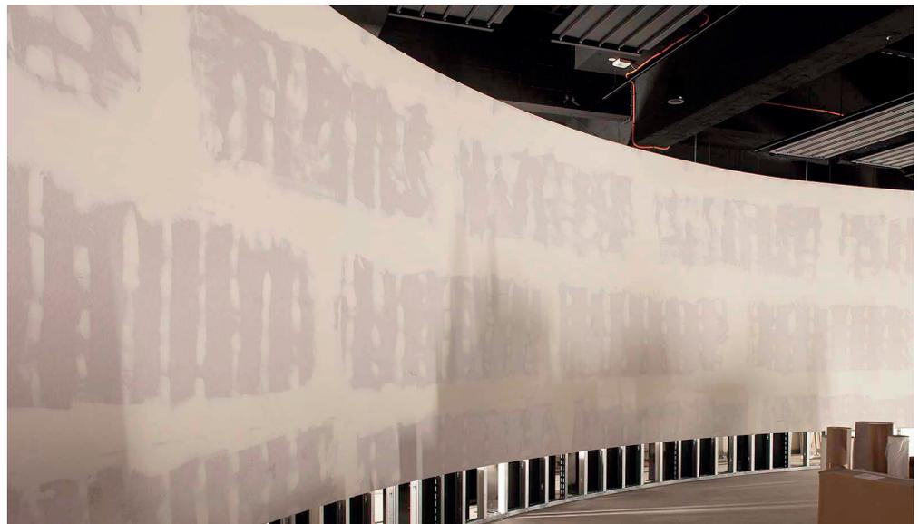
Zur einwandfreien Bild- und Filmwiedergabe war eine schatten- und streifenfreie Fläche ohne Fehlstellen gefordert. Die Grund- und Standardverspachtelung erfolgte mit dem Siniat-Produkt Pallas fill B. Zum Erreichen des optimalen Oberflächen-Finish Q4 wurde die Spachtelmasse Pallas easy verarbeitet.
