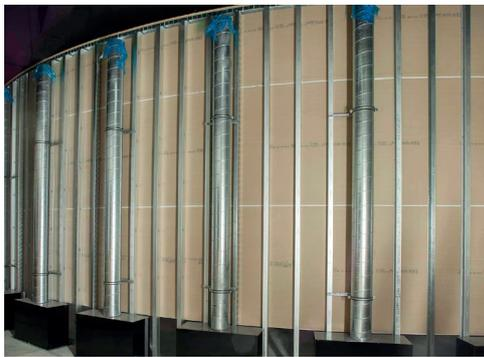
Ohne Deckenanbindung und nur im Boden verankert bieten die mit verkürztem Abstand montierten UA-Profile den stabilen Rahmen für die Projektionswand, welche mit der biegsamen Siniat LaCurve realisiert wurde. Zur Fixierung der Form wurde am oberen Ende ein dezenter Holzrahmen integriert.
