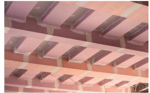
*Durch den Einsatz von im Werk vorgefertigten gefrästen Flamtex A1 Formteilen, konnten der Kantenschutz sowie zusätzliche Spachtel- und Schleif- Arbeitsgänge eingespart werden.*
