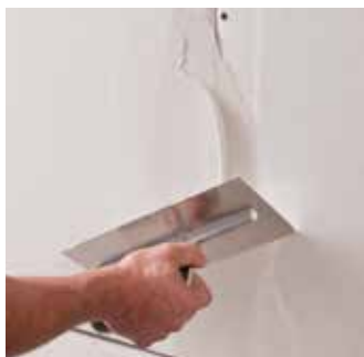
Napunite bočni rub preko spoja
