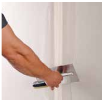
Povucite alat preko bandaž trake; dopustite da se sloj ispune stegne
