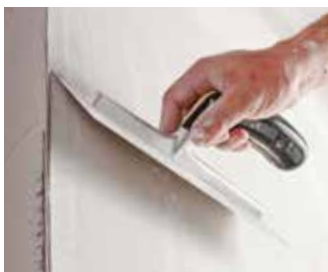
Poravnajte površinu s ostatkom ploče
