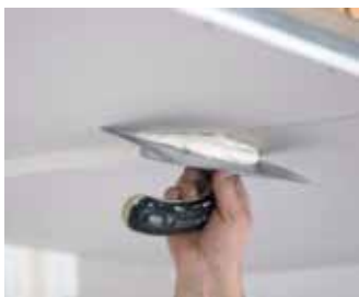
Ispunite spojeve i vrhove vijaka
