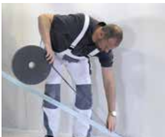
Zalijepite brtvenu traku na dno okvirnih profila
