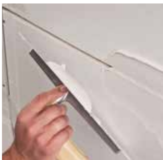
Za prvi ciklus ispune: Ispunite poprečni rub preko spoja
