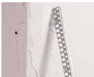
Na kut nanosite sloj ispune
