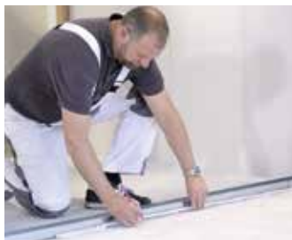
Označite pozicije vertikala
