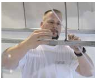
Spojite vješalice na potkonstrukciju
