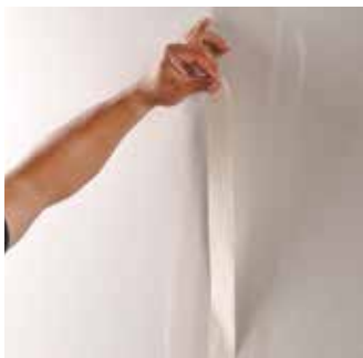
U površinski sloj obloge napunjene ispunom umetnuti bandaž traku
