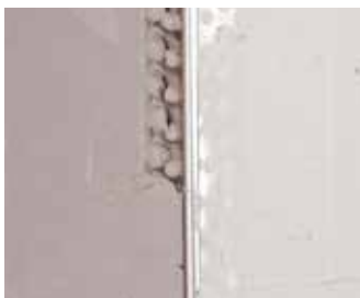
Nanesite prvi sloj ispune preko profila
