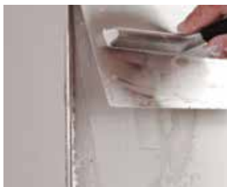
Dodati bandaž traku s obje strane profila (opcionalno)
