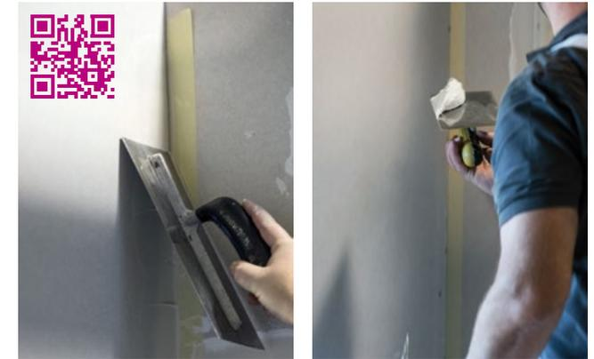
Anschließend wird die Fuge zwischen dem Trennstreifen und der Plattenkante mit Pallas fill verspachtelt. Sobald die Spachtelmasse trocken ist, kann der überstehende Streifen direkt in der Ecke mit einer scharfen Klinge angeschnitten und abgezogen werden.
