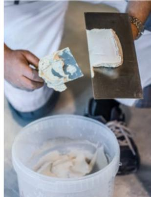
**Nach dem Trocknen der ersten Lage können Sie bereits nach 2–3 Stunden mit Fugenfüller nachspachteln, bis zum Erreichen eines stufenlosen Übergangs zur Plattenoberfläche (entspricht Q2-Oberfläche).**
