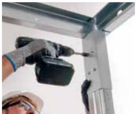
Ist eine Verlängerung des Raumsystem-U-Profils erforderlich, so kann dies mit einem 300 mm langen C-Profil erfolgen, das mittig verschraubt wird (4 Schrauben  $\geq 4,2 \times 13$  mm pro Seite im U-Profil).
