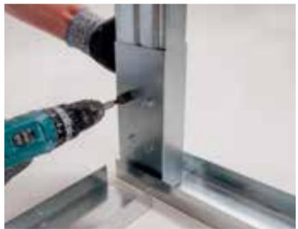
Zur besseren Fixierung der Raumsystem-C-Stützen sollten kurzfristig Gipsplattenreste als Montagehilfe an der Stütze verschraubt werden.
