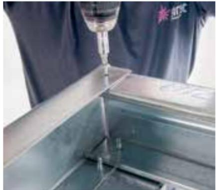
Von oben wird das Raumsystem-Weitspannträgerprofil mit zwei Blechschrauben ( $\geq 4,2 \times 13 \text{ mm}$ ) mit dem Raumsystem-U-Profil verschraubt.
