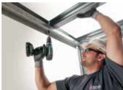
Die weitere Verschraubung erfolgt im regelmäßigen Abstand von  $\leq 500 \text{ mm}$  immer höhenversetzt zum mittleren Steg. Der Abstand der Schrauben zum unteren bzw. oberen Profilflansch beträgt 30 mm.
