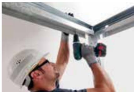
Es ist darauf zu achten, dass das obere UW-Profil bündig mit der Außenkante der Raumsystem U-Profile/Weitspannträger befestigt wird bzw. vormontiert ist, damit die spätere Beplankung flächig angebracht werden kann (Verschraubungsabstand ca. 25 mm vom Steg des Weitspannträger-U-Profils).
