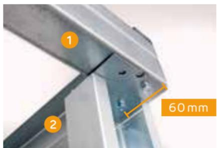
Das erste Raumsystem-Weitspannträgerprofil als Abschlussprofil im Eckbereich über dem Decken-SR-Verbinder in das Raumsystem U-Profil einschieben und außenbündig ausrichten.
