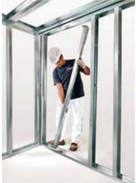
Für Türbreiten  $\leq 885$  mm kann der Türsturz mittels UW-Profil hergestellt werden.
