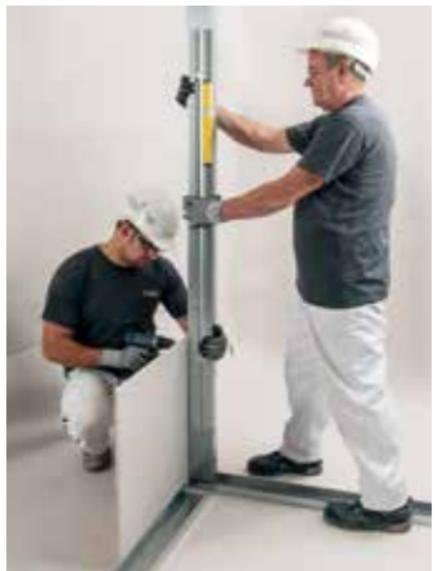
Für den Deckenanschluss wird der SR-Verbinder zunächst lose über die Raumsystem-C-Stütze geschoben, so dass er später in der Höhe noch justiert werden kann (50 mm).
