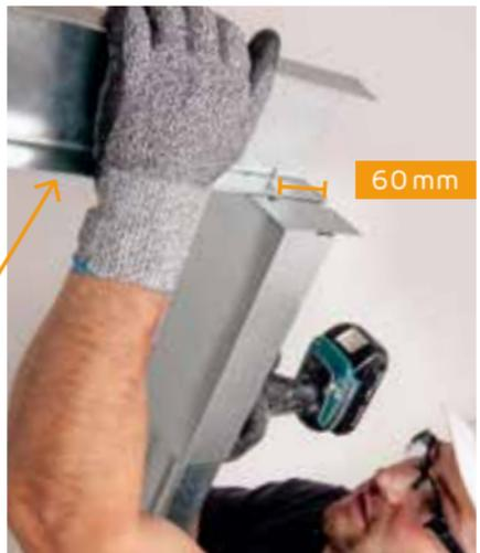
**Alternative Montagemöglichkeit mit vormontiertem UW-Profil unter Raumsystem U-Profil.**
