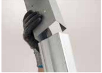
**Alternative Montagemöglichkeit mit vormontiertem UW-Profil unter Raumsystem U-Profil.**
