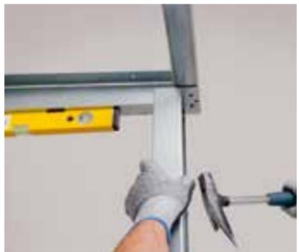
Die Höhe des Raumsystems kann mittels Wasserwaage bzw. Lasersystem ausgerichtet werden.
