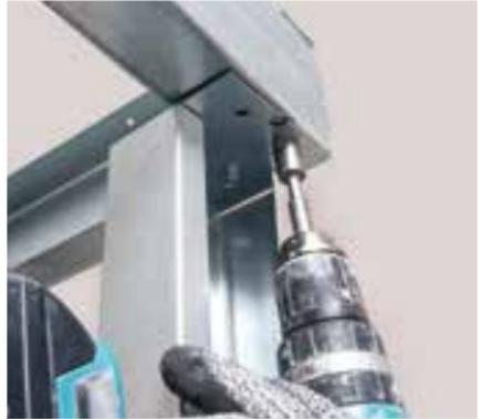
Das Raumsystem-Weitspannträgerprofil ist von unten und oben zu verschrauben.
