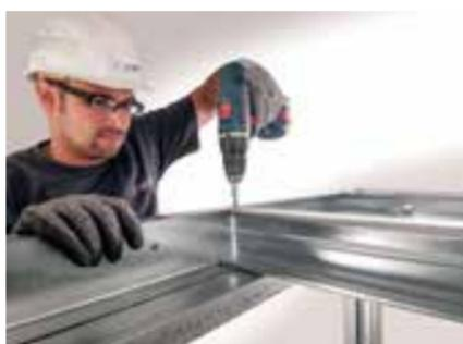
Bei Ausführung als Doppel-Weitspannträger werden die Profile Rücken-an-Rücken mit Blechschrauben (SuperTEKS  $6,3 \times 19 \text{ mm}$ ) verbunden. Im Abstand von 100 mm vom Profilende ist die erste Verschraubung anzuordnen.
