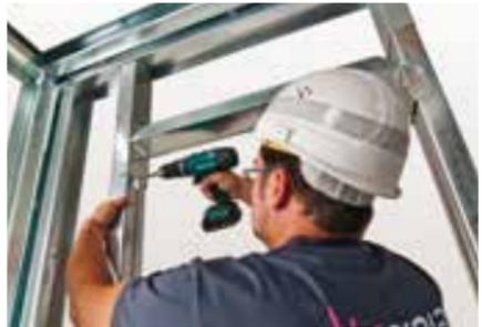
Für Türbreiten von  $> 885$  mm bis  $< 1250$  mm sind verstärkte Profile als Türsturz zu montieren.
