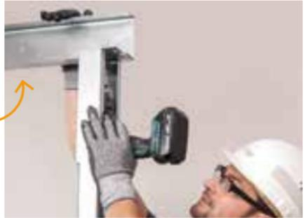
Alternativ besteht die Möglichkeit das Raumsystem U-Profil mit dem UW-Profil vorzumontieren. Das erleichtert das Aufsetzen und Verschrauben mit dem SR-Verbinder.
