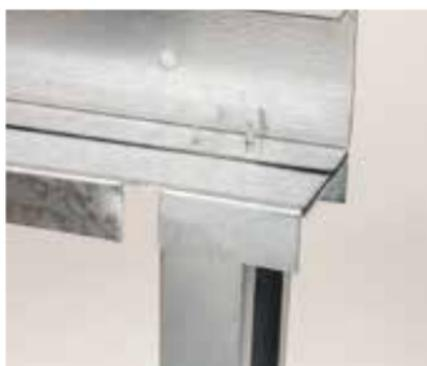
Zur besseren Verschraubung der Eckbereiche wird ein UW-Profil über die Raumsystem-C-Stütze gestülpt und oben und unten mit je einer Blechschraube  $\geq 4,2 \times 13 \text{ mm}$  fixiert.
