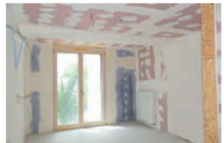
Die Innenbekleidung erfolgte mit der Siniat LaPlura Hartgipsplatte, die durch ihre holzfaserverstärkte Struktur die Statik der Konstruktion weiter verbesserte und den Schallschutz zusätzlich erhöhte.
