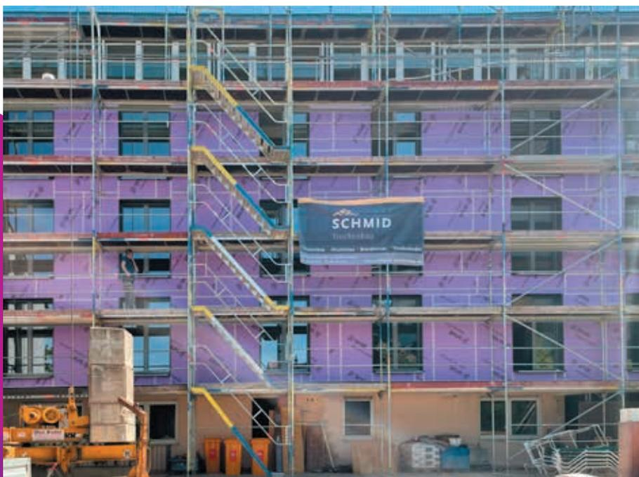
*Durch die Außenbeplankung mit der witterungsbeständigen Spezialplatte Siniat Weather Defence konnte der Innenausbau während der Planungs- und Umsetzungsphase des Wärmedämmverbundsystems und der finalen Fassadengestaltung, problemlos weiterlaufen*
