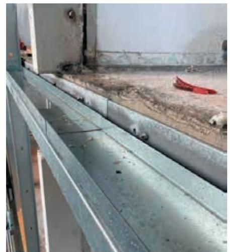
Über ein Stahlwinkelprofil wurde die Wand-konstruktion für die nichttragenden Außen-wände befestigt.
