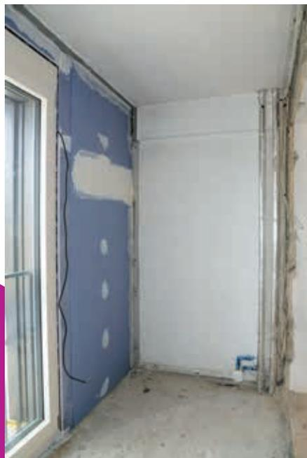
Im Sanierungsverlauf mussten die alte Balkonbrüstung und Fassade der vorgesetz-ten Fassadenausfachung SK115 weichen. Was die Innenräume optisch und auch in der Fläche vergrößerte sowie brand- und schallschutztechnisch optimierte.
