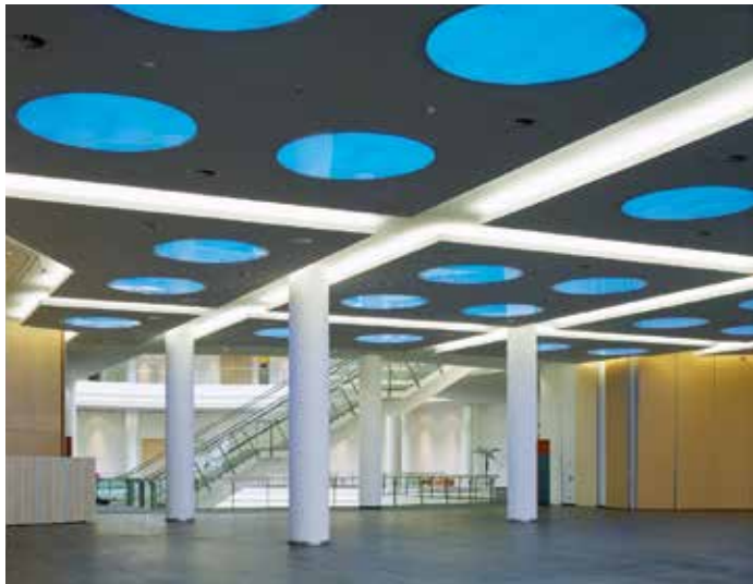
In den abgehängten Deckenspiegel im Mehrzweckraum Sydney sind Leuchtkörper sowie Acrylglasscheiben eingearbeitet.
