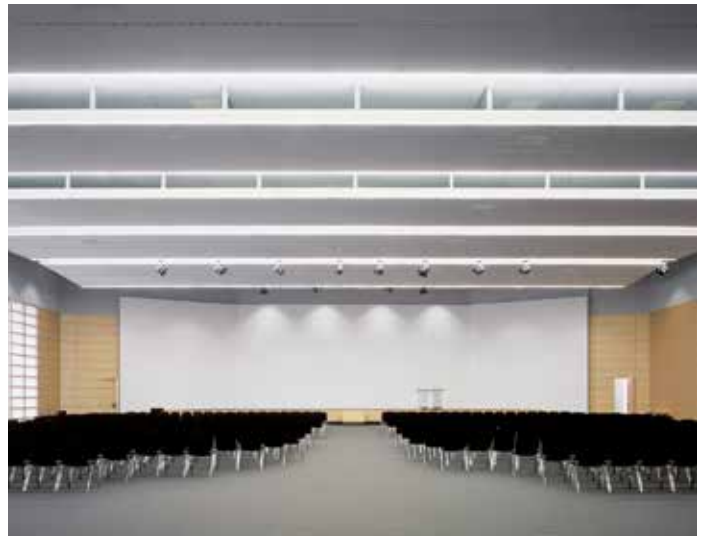
Im Konferenzraum Tokio sorgen acht unterschiedlich geneigte Deckensegel für optimale Reflexion.
