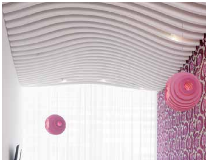
In den vier Suiten finden sich 181 Deckenlamellen mit Längen von 471 bis 6.302 mm.
